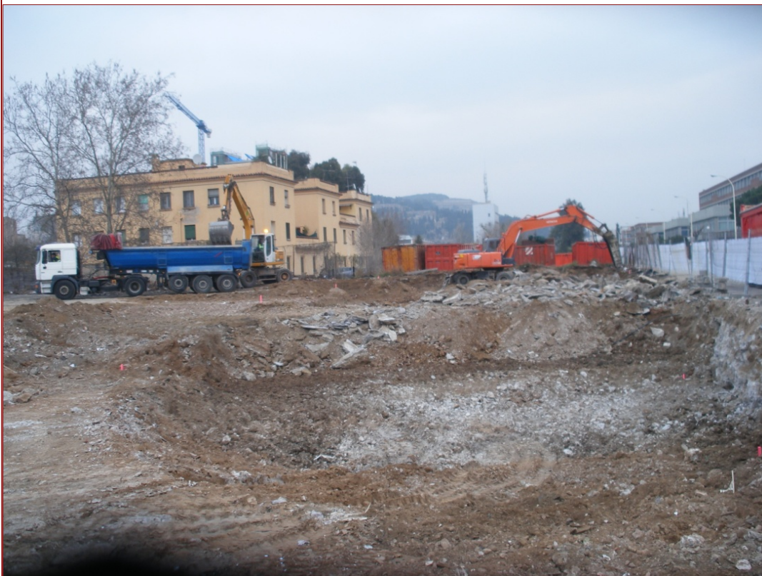
Foto 3. Sector 1. 1-Rebaixos fets al primer tram del sector, prop del carrer de l'Acer (4).
