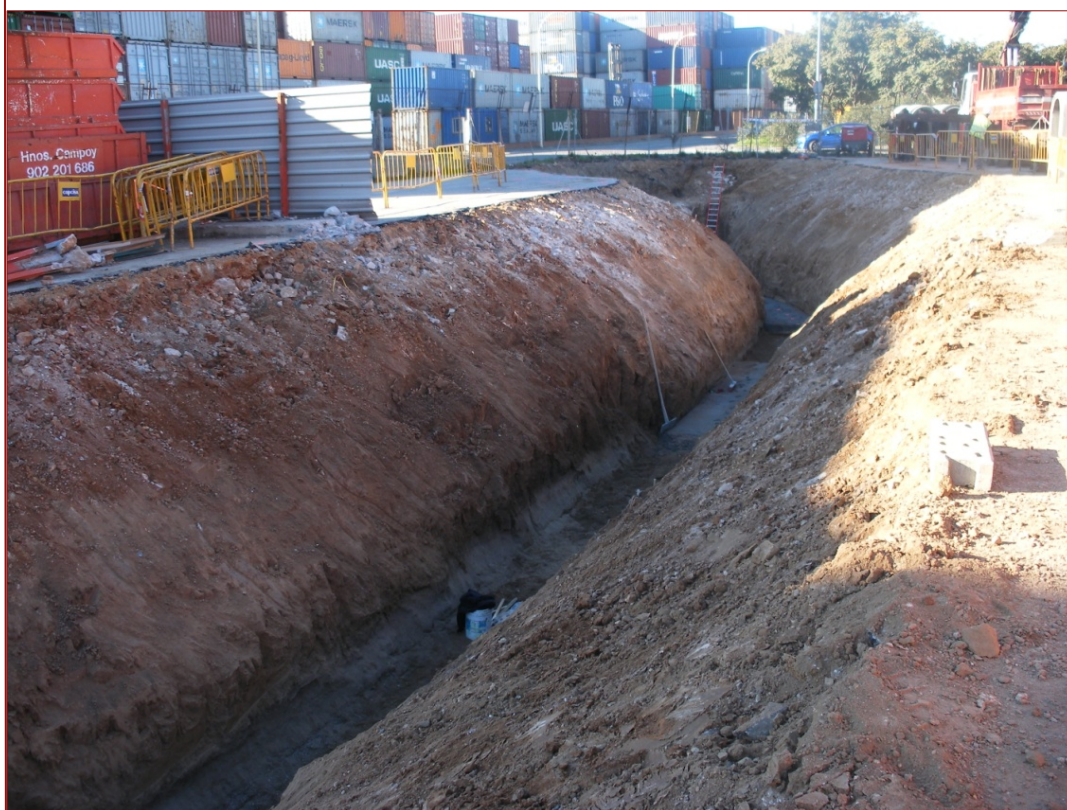
Foto 2. Sector 1. 2-Primers 50 metres de la rasa del col·lector al carrer dels Motors (8).
