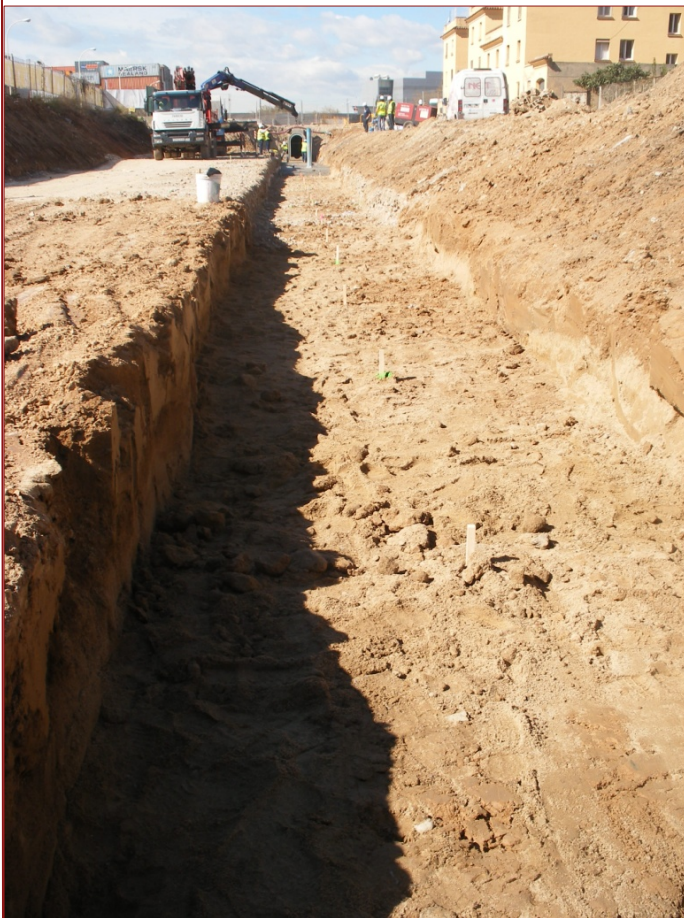
Foto 5. Sector 1. 6-Rasa del col·lector entre els 201 i 400 metres (4).
